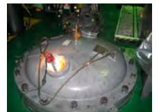
中修 (再含浸工事)
