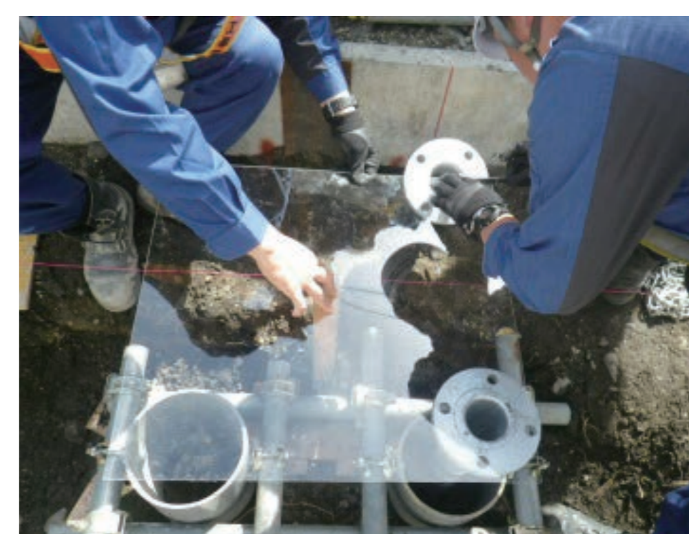
検測状況 (杭芯位置)
