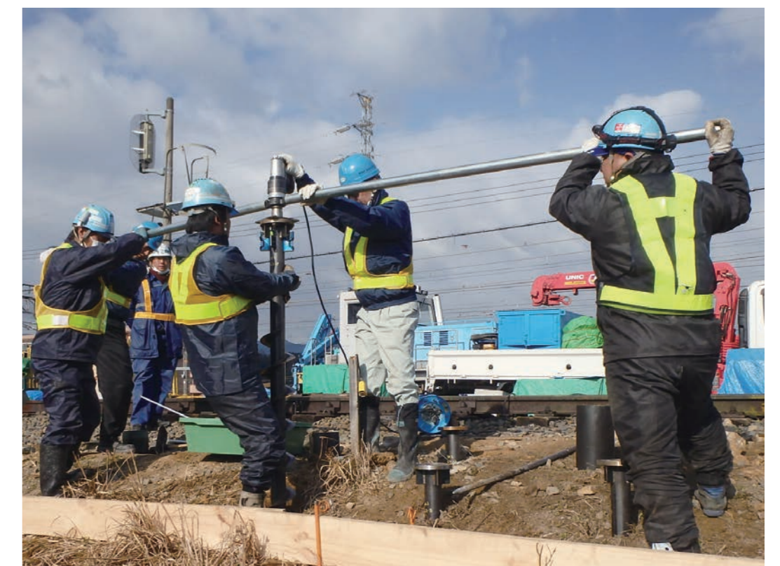
杭打設（人力施工）
