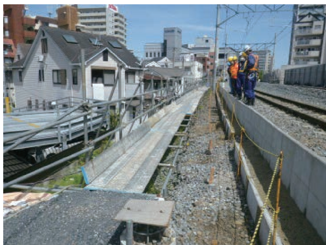
②足場組立
