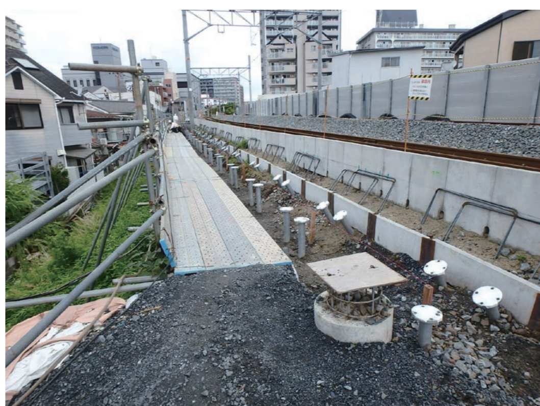
④杭打設完了
