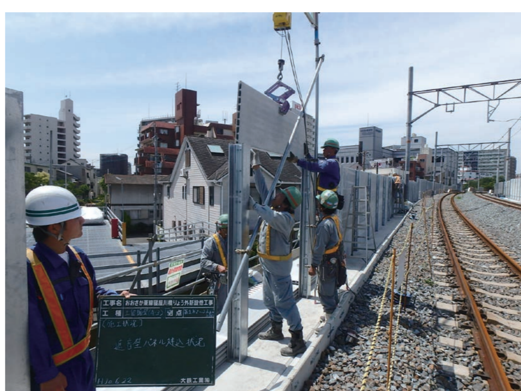
⑧防音壁パネル設置
