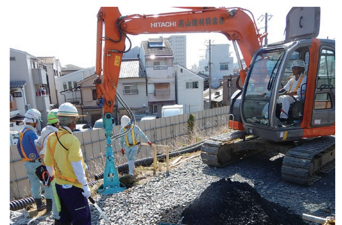
鋼管杭掘削（機械施工）
