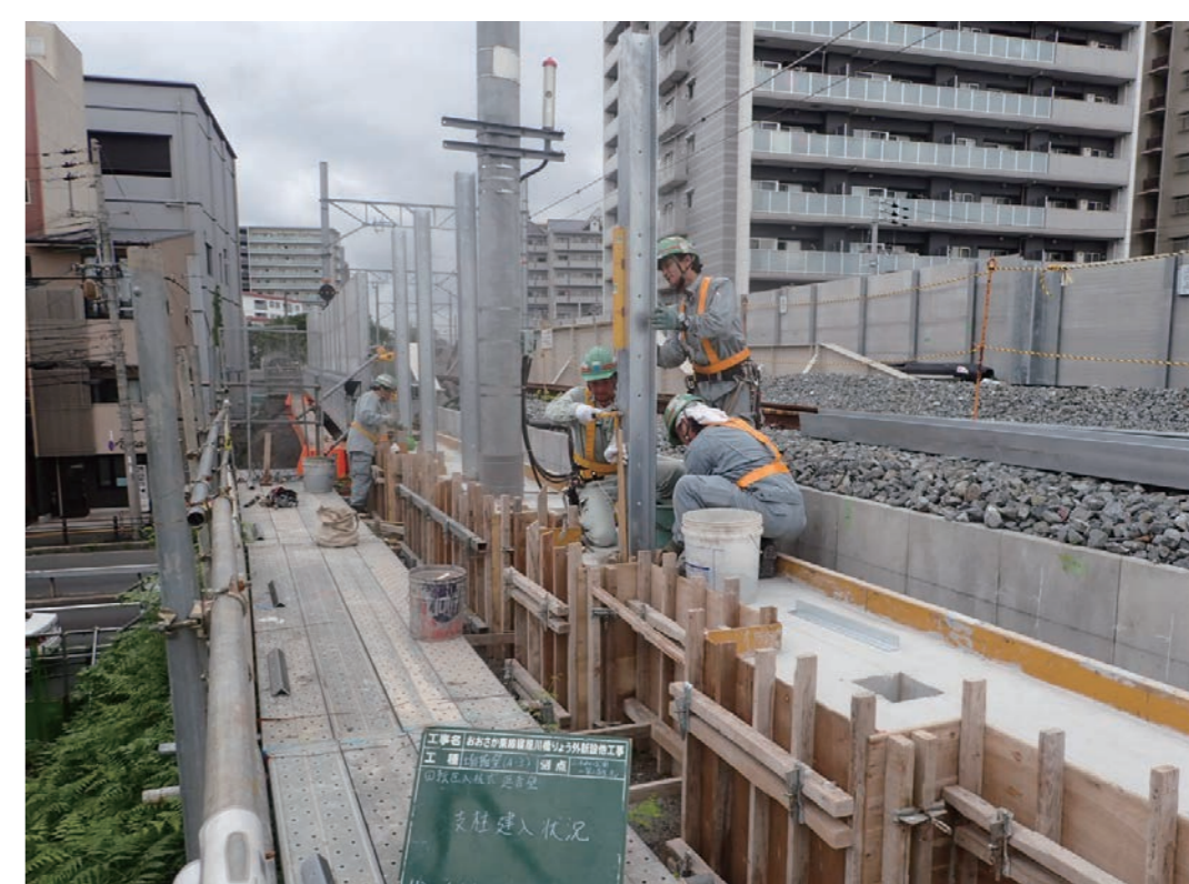
⑦支柱建込工
