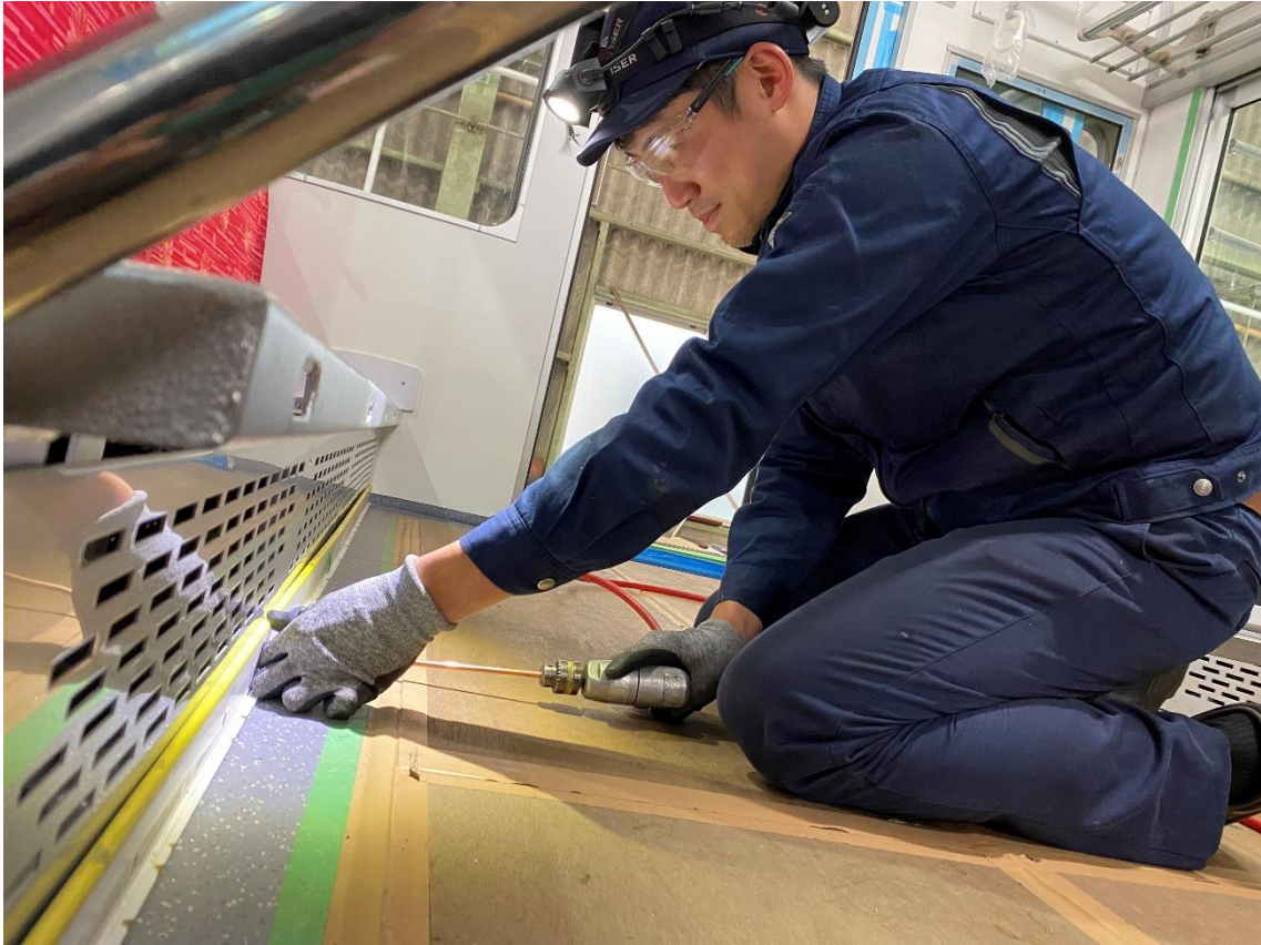
丁寧に巾木を取り付けていきます。
